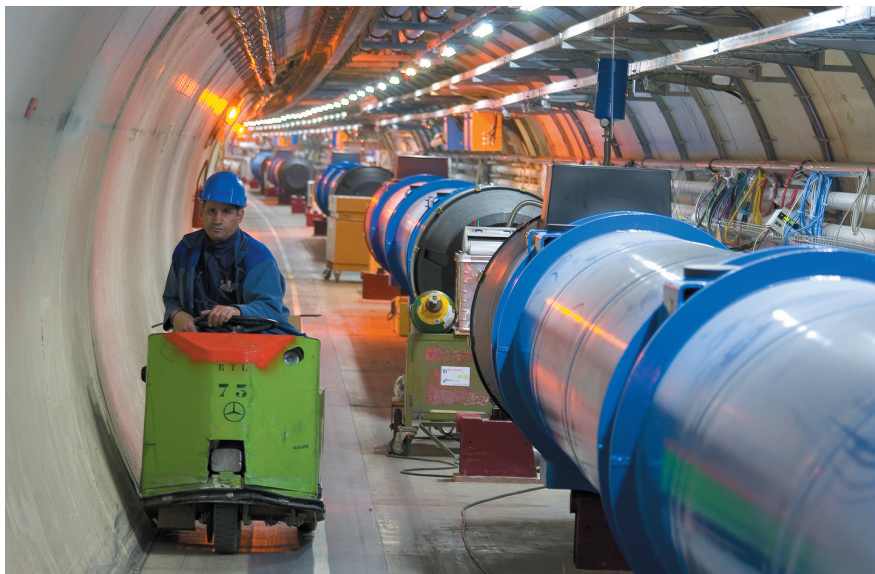
April 2005: de första magneterna i LHC installeras i tunneln. Foto: CERN
